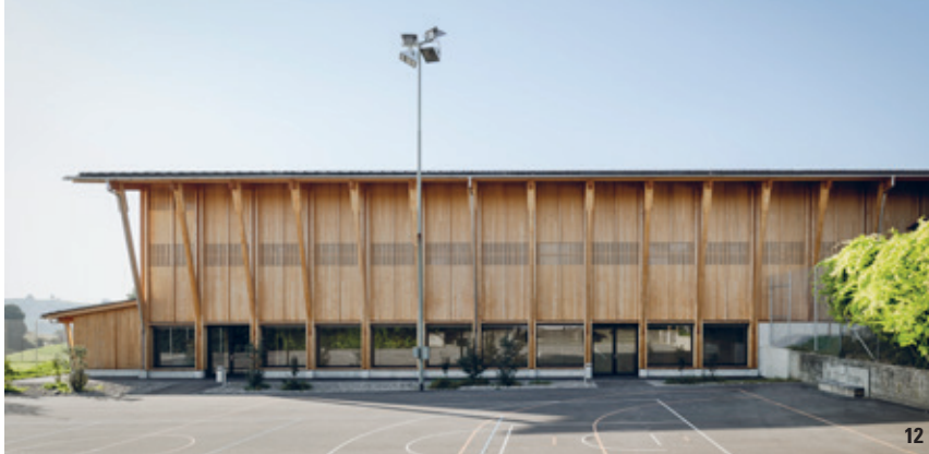
12 Die kompakte Bauform ohne Keller, eine einfache Haustechnik und die PV-Anlage (Dach) tragen zu minimierten Investitions- und Betriebskosten bei.
