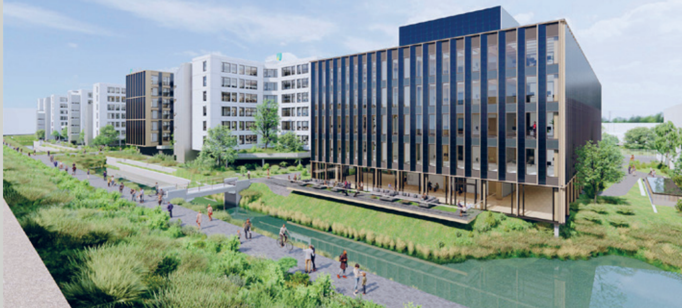
Der Hauptsitz der niederländischen Bank ABN AMRO wird in Holzskelettbau erweitert.
