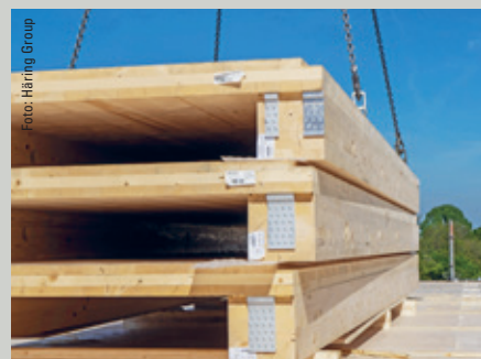
Die vorgefertigten Deckenelemente wurden mit etwa 7000 Verbindern LOCK T verbunden.
